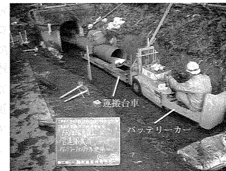
写真-1 管の搬入
