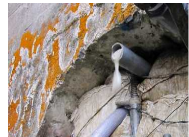
Pic. 7 エル外注入確認
