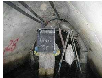
Pic. 6 エル外パック間仕切り
