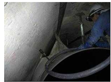
Pic. 5 浮上防止固定
