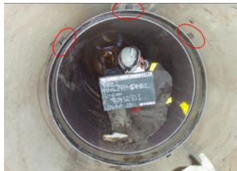
写真-7 管の浮上防止固定
