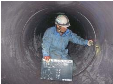
写真-10 ジョイント間隔測定
