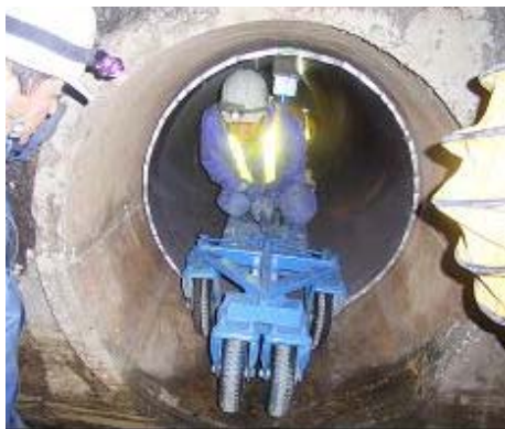
写真-5 管運搬状況
