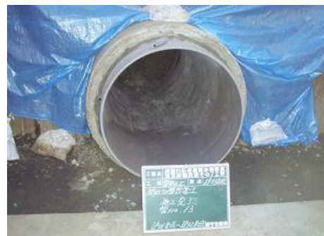
写真-8 間仕切壁（モルタルバック）設置
