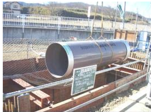
写真-3 立坑からの管吊り下ろし
