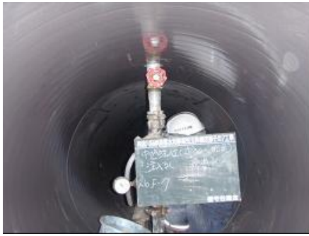
写真-9 エアーモルタル注入状況
