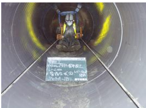
写真-6 管接合状況
