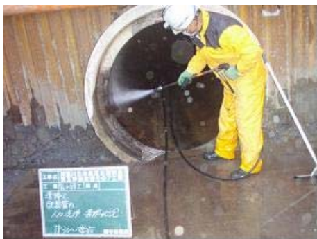
写真-2 既設水路内清掃状況
