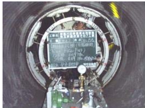
写真-11 テストバンド試験状況
