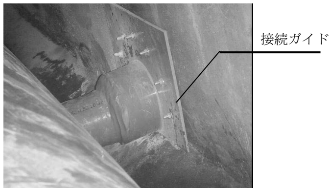
写真-2 取付管との接続
