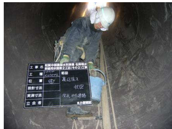
写真 9 裏込材充填確認状況
