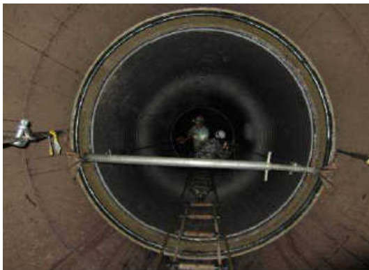
写真7 管接合状況
