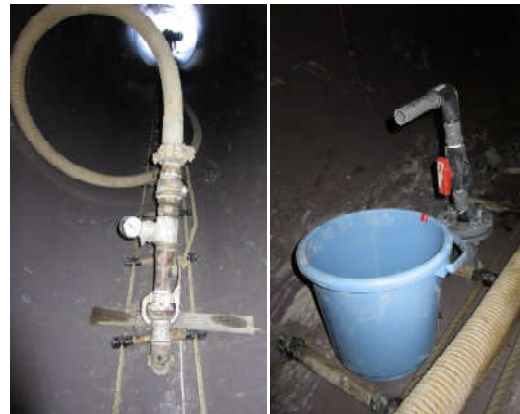
写真 8 (左) 注入口、(右) 充填確認口
