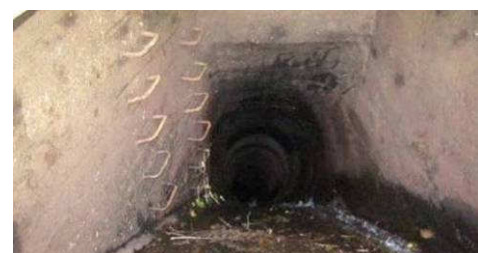
写真 2 上流側開口部
