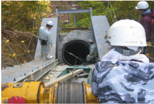
写真5 電動ウィンチによる管吊り下ろし (発進部)
