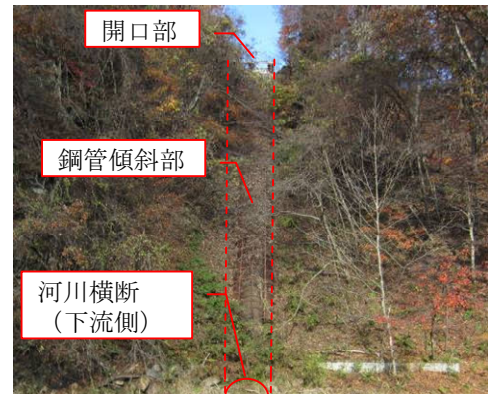
写真 1 鈴鴨第一サイフォン傾斜部
